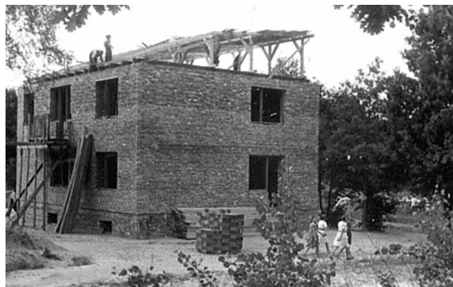
Ośrodek zdrowia przy ulicy Korallen Dębów w budowie. Zdjęcie z archiwum Grzegorza Fryszczyzna.
