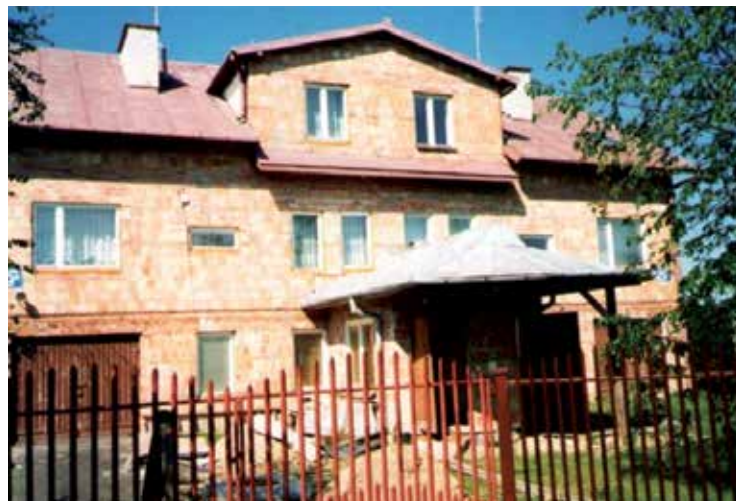
Dom w budowie
