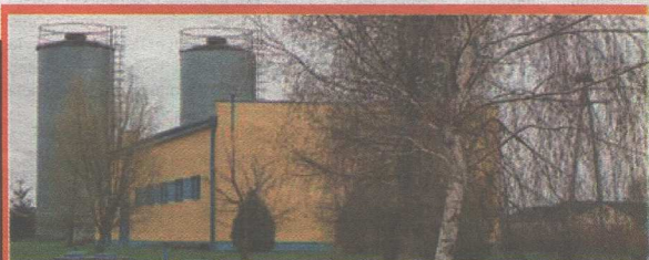
Stacja uzdatniania wody w Piekaciu
