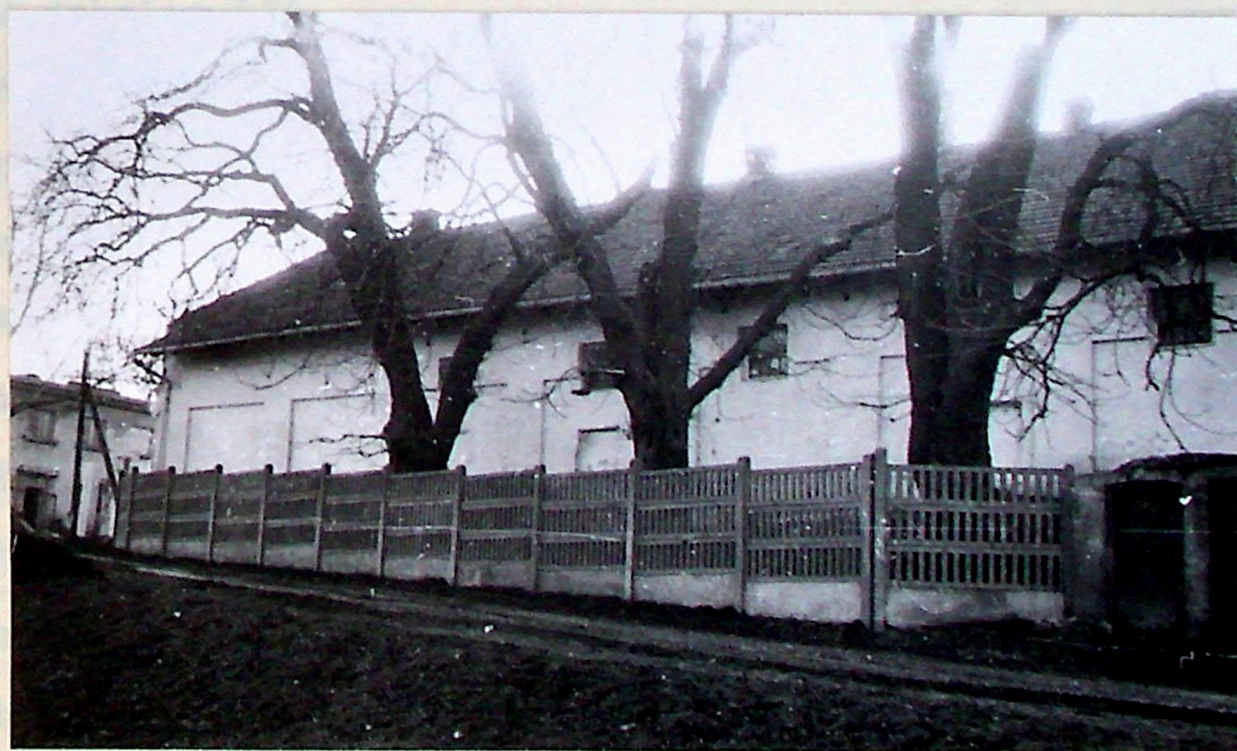
4/ Fragment budynków byłego folwarku /obecnie tuczarni trzody chlewnej/.
