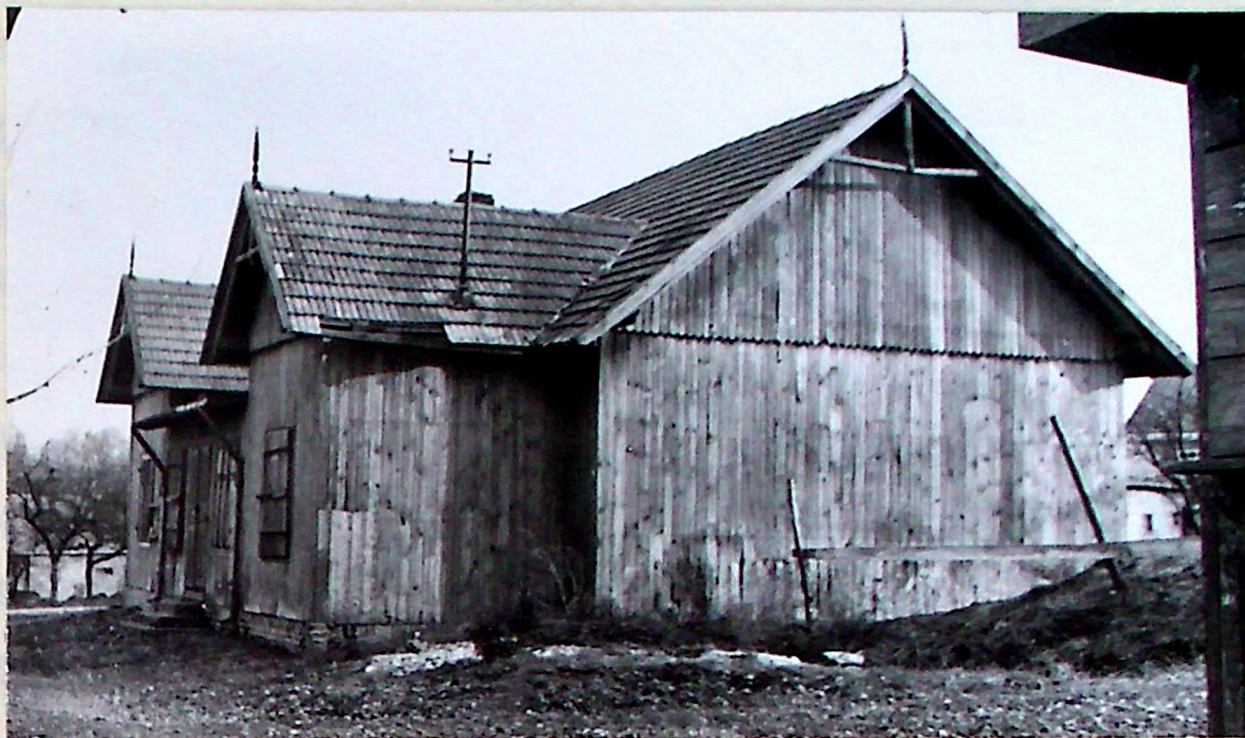
15/ Budynek starego Domu Społecznego.
