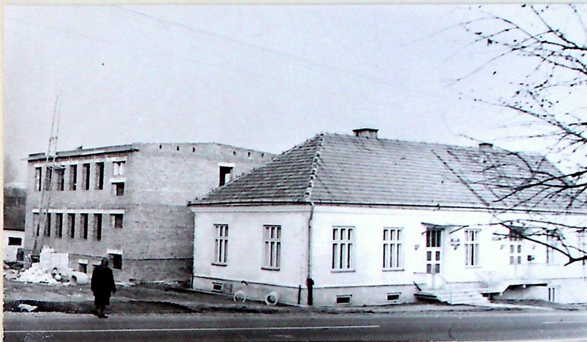
11/ Obecny i będący w budowie nowy budynek Urzędu Gminy.
