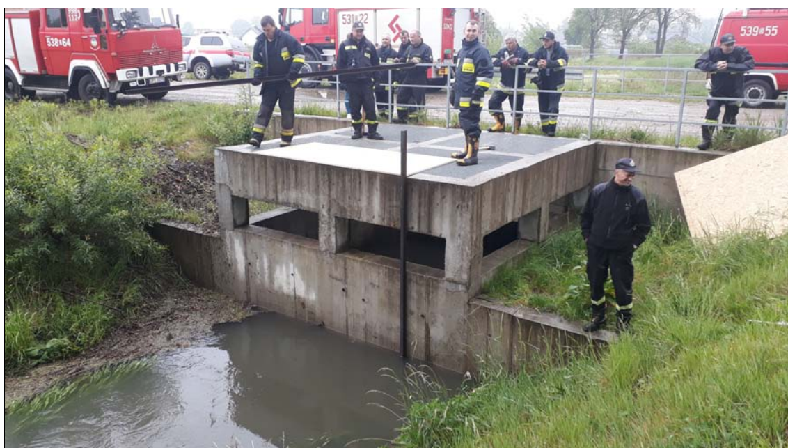
Rysunek 2.89 Budowa zastawki na cieku wodnym Kalina w Sobinie. Źródło: archiwum OSP Sobin.
