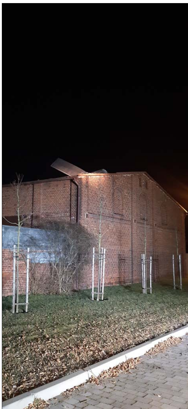
Rysunek 4.193 Poluzowana blacha na dachu w Sobinie. Źródło: archiwum OSP Sobin.
