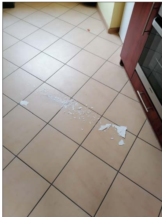
Rysunek 4.134 Cieknący dach w remizie. Źródło: archiwum OSP Sobin.
