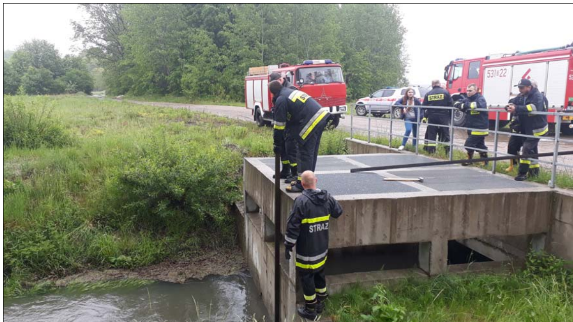
Rysunek 2.88 Budowa zastawki na cieku wodnym Kalina w Sobinie. Źródło: archiwum OSP Sobin.
